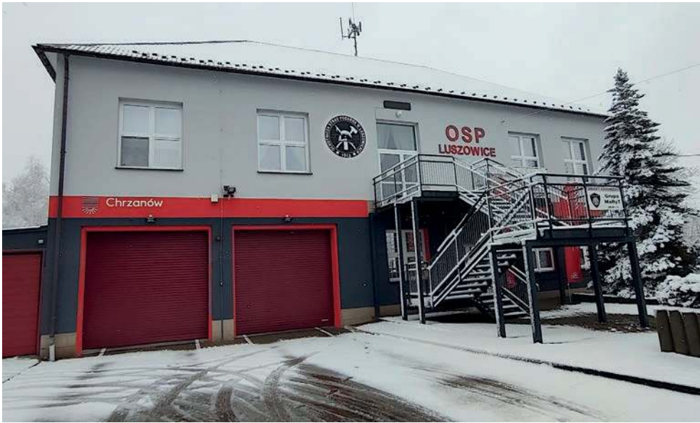
Strażnica w Luszowicach po termomodernizacji
