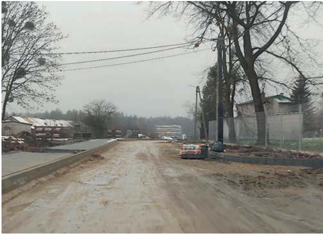
Budowana droga w chrzanowskim Kroczymiechu
