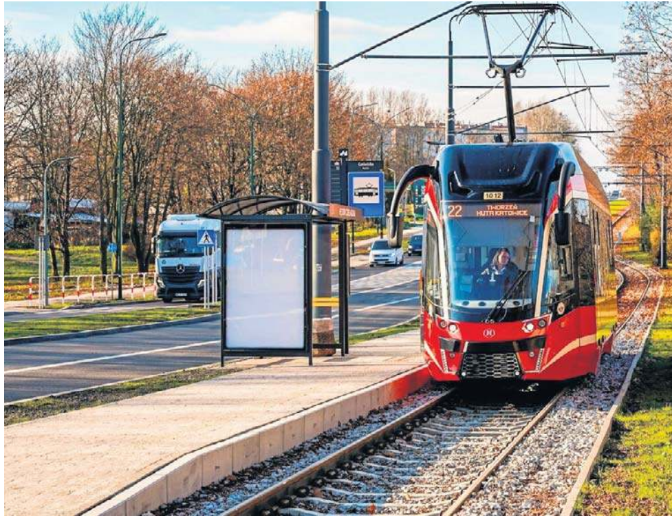
Tak prezentuje się nowe torowisko w Będzinie na odcinku od nerki do granicy z Czeladzią
