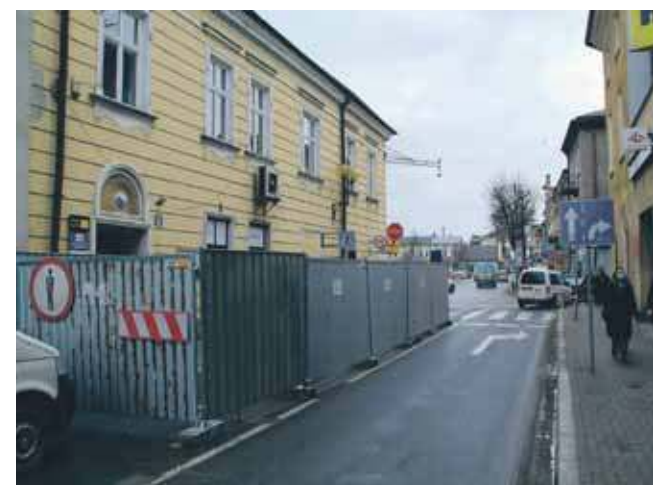
Budowlańcy rozpoczęli remont, kierowcy muszą uważać na korki.
