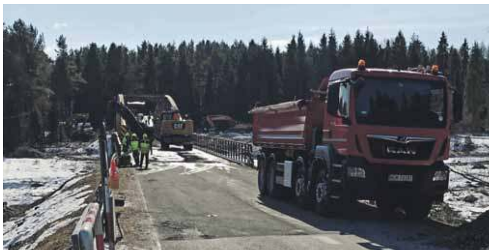
Ruszyły prace rozbiórkowe na moście w Trybszu
