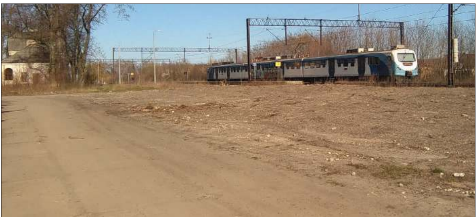
■ Rampa służąca kiedyś do rozładowywania towarów z wagonów został rozebrana
