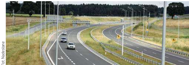
Fot. Najdalej W ramach inwestycji powstanie 71 km drogi ekspresowej S7
