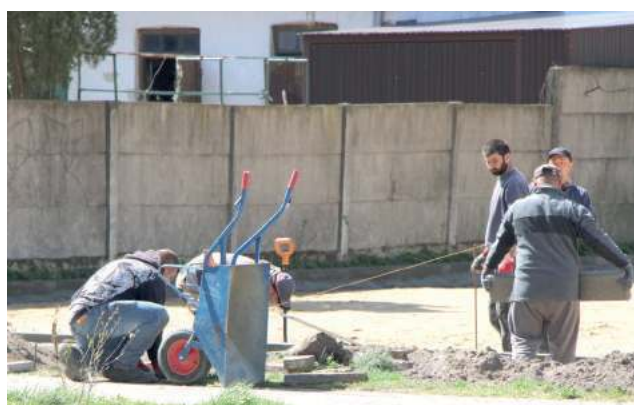
Prace przy budowie placu zabaw na os. Szaniawskiego wreszcie ruszyły
