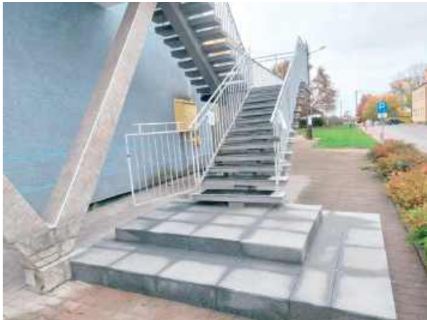
Remont schodów jest już prawie zakończony
