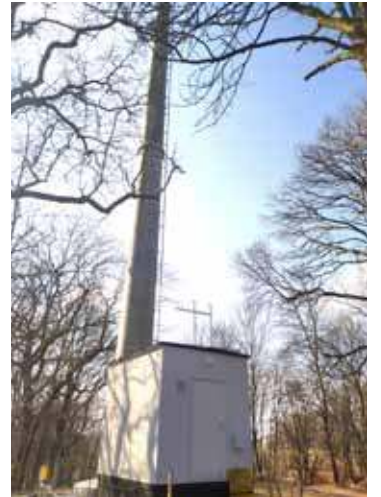
Budowany obiekt ma kilkadziesiąt metrów wysokości
