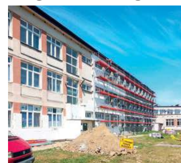
FOT. UGIM W ŻUROMINIE
