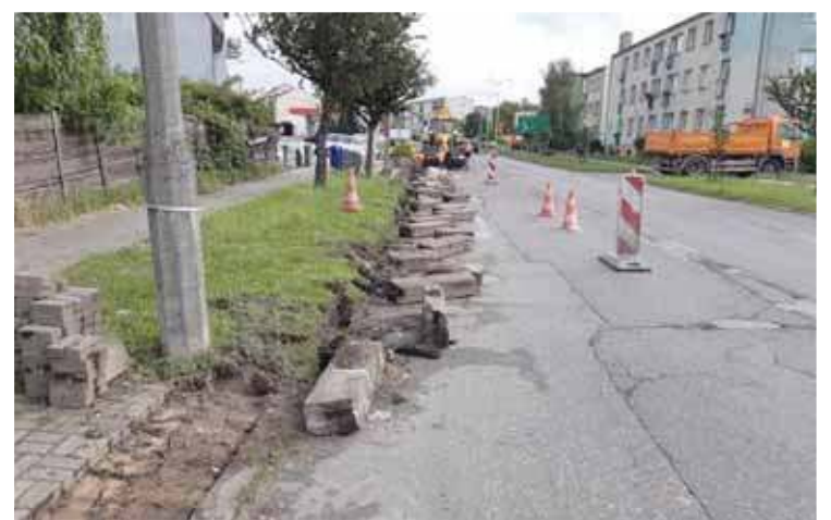
Wymiana krawężników na ul. Grzebskiego
