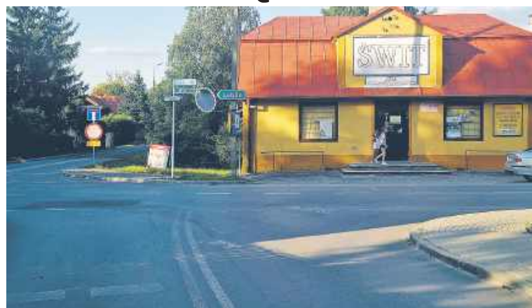
Na tym skrzyżowaniu ulic Kościuszki, Szkolnej i Kołowrót ma powstać rondo, bez którego nowa przeprawa mostowa na rzece Wieprz nie będzie miała sensu
