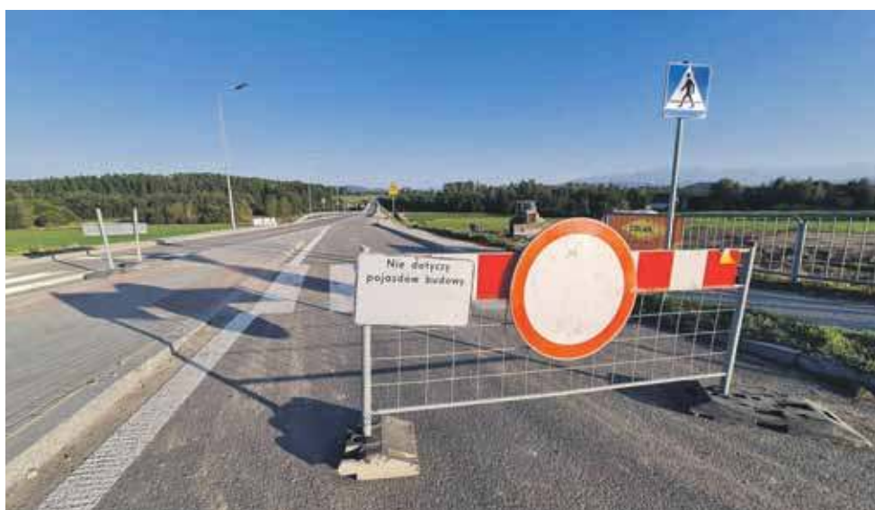
Mimo zakazu wjazdu, z nowego fragmentu obwodnicy kierowcy już korzystają, omijając w ten sposób korki w Ostrowsku.
