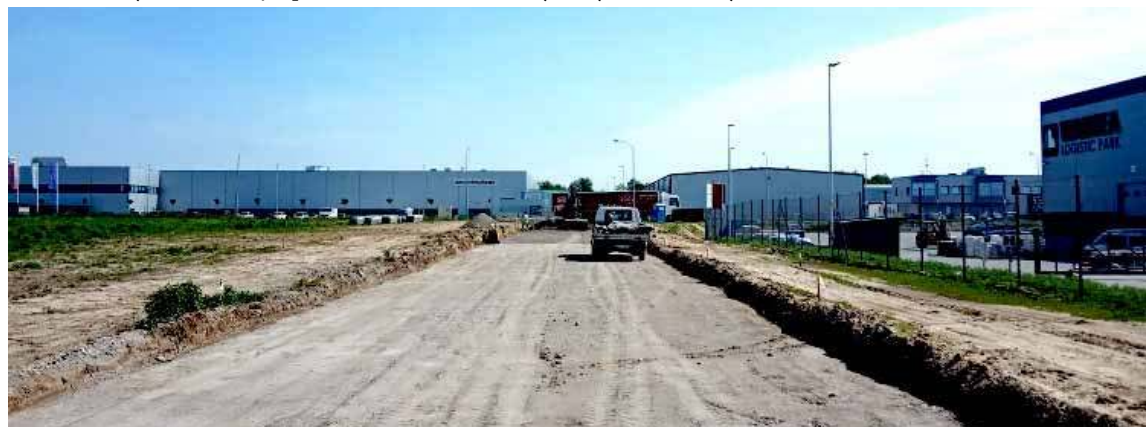
Ruszyły roboty związane z przedłużeniem i rozbudową ulicy Metalowej
