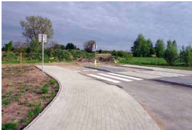
Zanim budowa obwodnicy ruszy, miasto zamierza wybudować tzw. trasę śródmiejską. Ulica Piłsudskiego w Sokółce zostanie przedłużona aż do Żanecina. fot. KW
