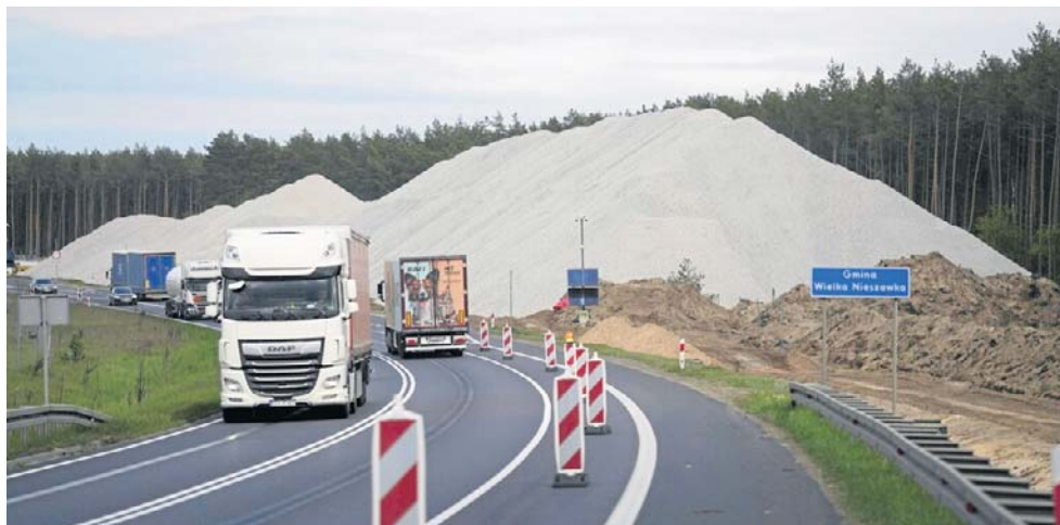
Budowa fragmentu trasy S10, będącego południową obwodnicą Torunia, rozpoczęła z opóźnieniem się na początku kwietnia tego roku
