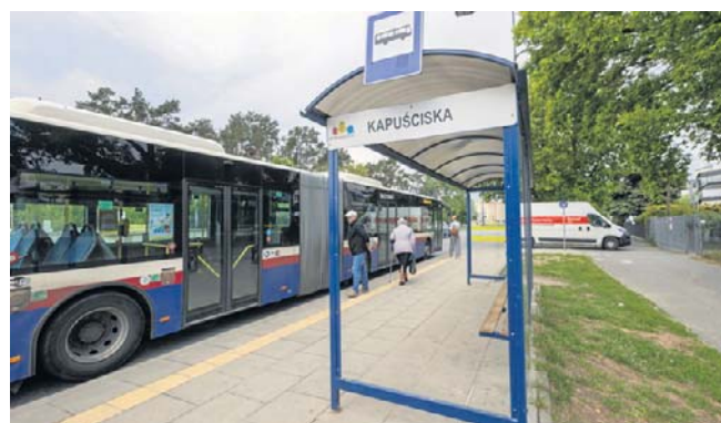
W wiacie na przystanku autobusowym przy pętli Kapuściska zniszczona została jedna z bocznych szyb
