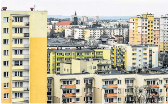
Winda w bloku to marzenie wielu mieszkańców. Niestety, większość nie ma szans na to udogodnienie
