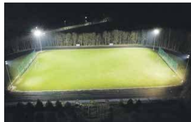
Samorząd wykonał profesjonalne oświetlenie stadionu w Jabłoni z wykorzystaniem opraw projektowych LED, a także nawodnienie płyty boiska
