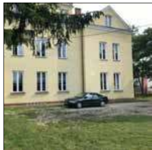
Przy GOK-u w Łomazach zostanie wybudowany nowy parking. Środki na ten cel zostały zabezpieczone na ostatniej radzie gminy
