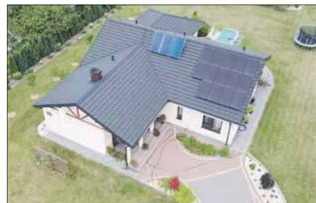
Projektem OZE objęte zostały domy jednorodzinne oraz budynki użyteczności publicznej
