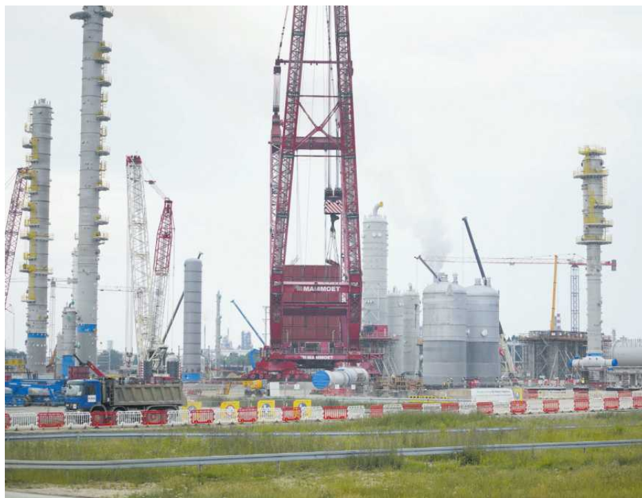
• Stara Biała, budowa kompleksu Olefiny FOT. PIOTR HEJKE / AGENCJA WYBORCZA.PL
