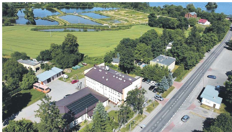
Zielona działka przy stawach u góry kadru – to tutaj, na powierzchni ok. 4 hektarów, powstanie nowy park planowany przez Gminę Siemień
