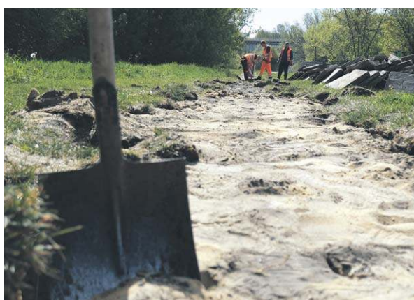
Prace przy remoncie ul. Janowskiej rozpoczęły się
