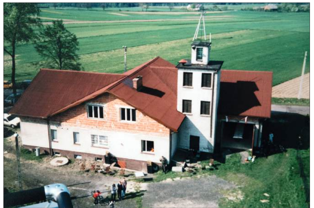
■ Budynek OSP w trakcie rozbudowy
