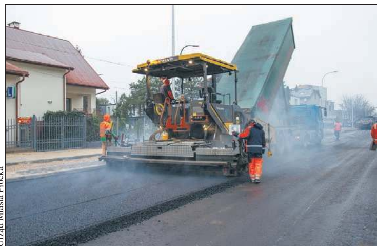
Na ulicy Spółdzielczej wykonanych zostało około 70 procent prac
