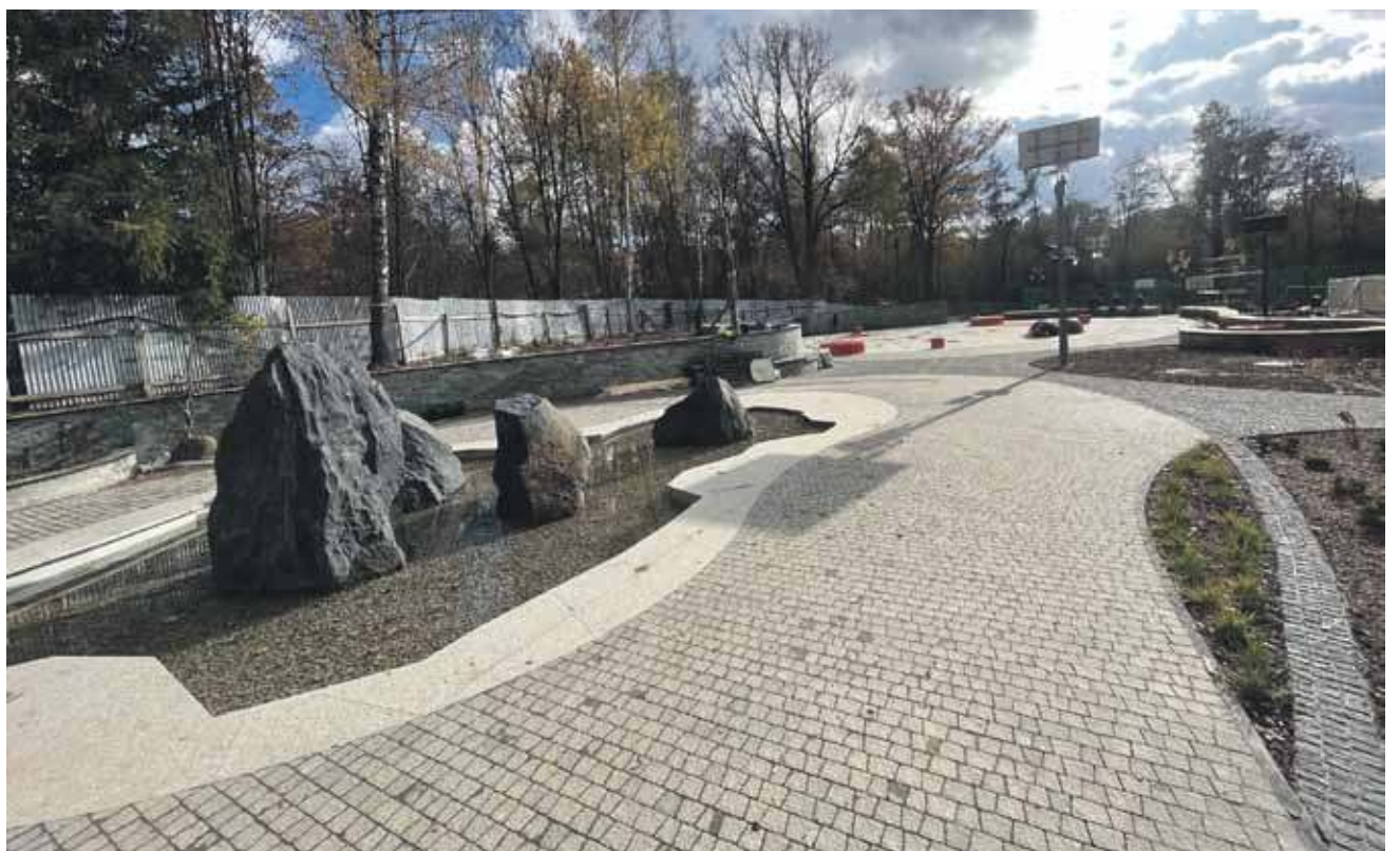
Wodny plac zabaw już na ukończeniu.
