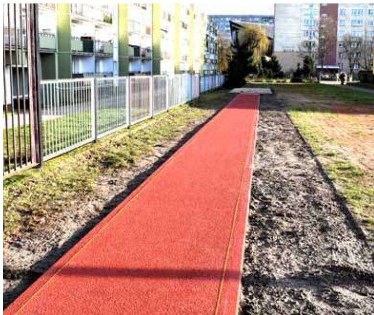
Elementem inwestycji jest nowa skocznia do trenowania skoku w dal
