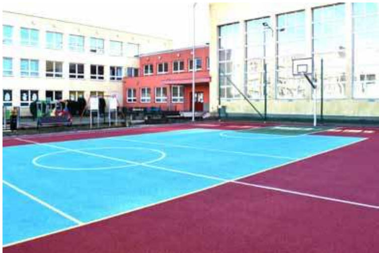
Przy Jedenastce wykonane zostało wielofunkcyjne boisko
