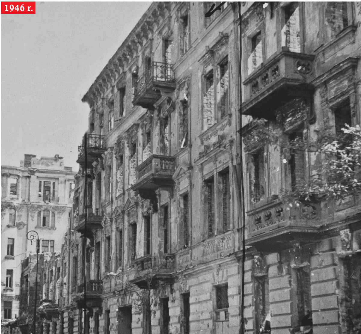
Spalona kamienica przy ul. Hożej 45 w 1946 r. Akta BOS. Zbiory Archiwum Państwowego w Warszawie | fot. Tomasz Hamrat/Gazeta Polska
