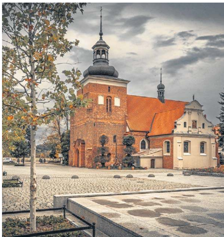
W murach kościoła św. Jana Chrzciciela znajdują się cegły powodziowe, wskazujące historyczny poziom wody
