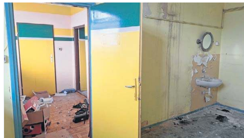
Tak wyglądają teraz pomieszczenia dworcowych biur
