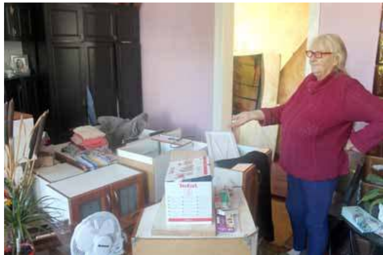
Pani Grażyna nie może zawiesić w kuchni tych mebli z powodu zwilgocenia i cieknięcia z sufitu wody
