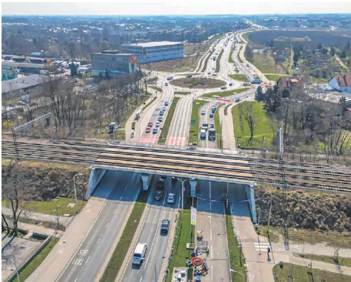
Gdy na wiadukt przeniesione zostaną pociągi pasażerskiej linii na Sobótkę, możliwe będzie wybudowanie tramwaju na Jagodno.
