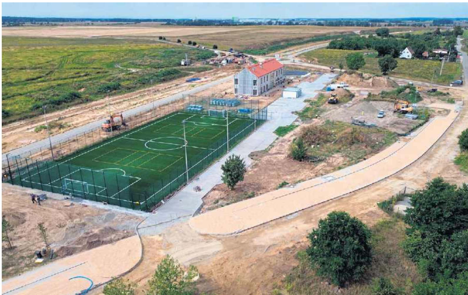
Orlik powstał w szczerym polu. teraz otaczają go zewsząd place budowy...
