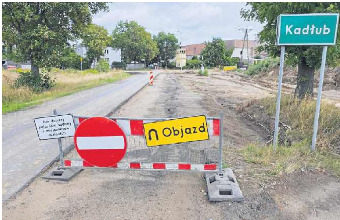
Niewielka wieś Kadłub stała się ogromnym, rozkopanym polem, na którym trwa wielka inwestycja
