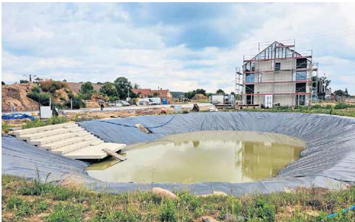
Wszędzie dookoła Kadłuba widać potężne zbiorniki na deszczówkę
