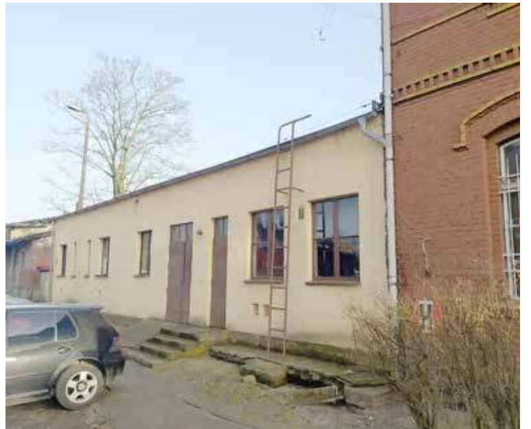
Ta drabinka będzie demontowana
