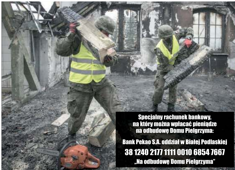
Terytorialsi pracują przy usuwaniu skutków pożaru i zabezpieczeniu budynku przed dalszym zniszczeniem
