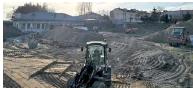
Trwa budowa nowoczesnego stadionu w Czemiernikach, na co gmina ma wydać 3 mln 600 tys. zł. Ujęte jest w tym dofinansowanie unijne w kwocie 1 mln 700 tys. zł. Zakończenie inwestycji zaplanowano na koniec czerwca 2021 r.
