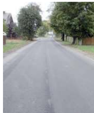
Przebudowana droga Wola Chomejowa - Brondzin
