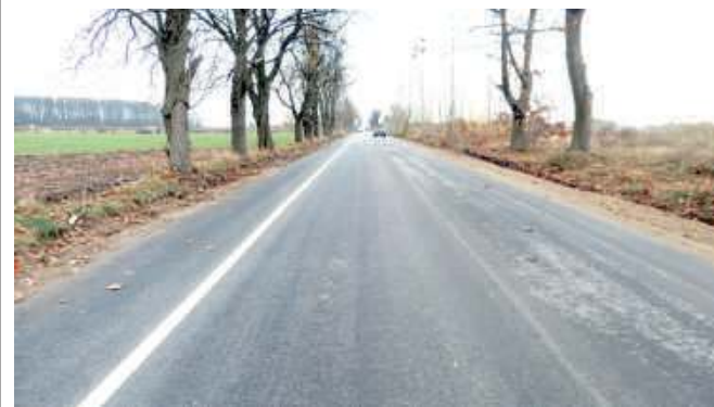
Zakończono przebudowę drogi powiatowej nr 1229L Białka - Ustrzesz (etap III) na odcinku około 980 mb. Wartość robót: 600 000,00 zł brutto. Wykonawcą prac jest firma PRD Lubartów SA.
