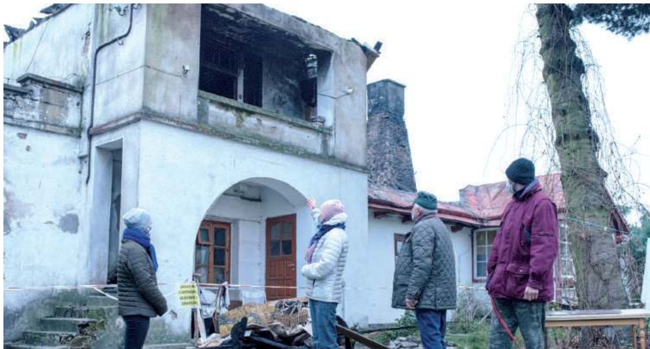
W budynku po byłej Spółdzielni Rolno-Produkcyjnej do niedawna mieszkali w oddzielnych mieszkaniach cztery rodziny. Aż do tragedii spowodowanej pożarem w sierpniową sobotę
