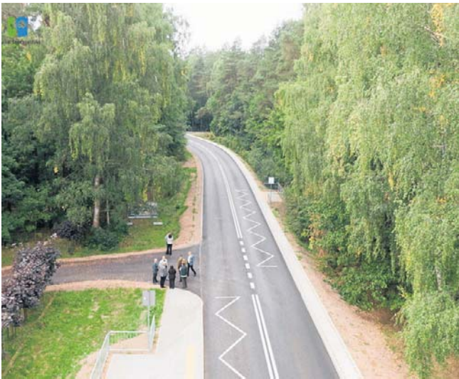
Wyremontowany odcinek drogi powiatowej między Starogardem Gdańskim a Lipinkami Królewskimi
