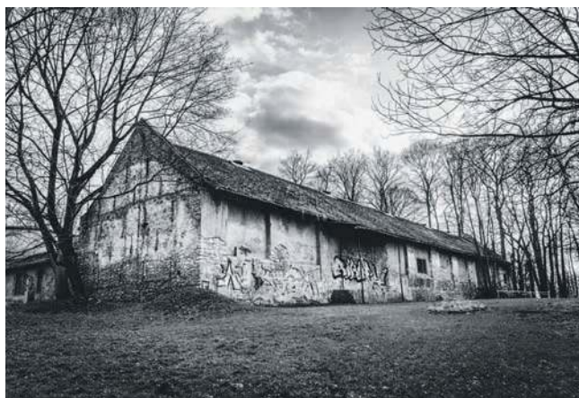
Jedyne pozostałe zabudowania folwarczne
