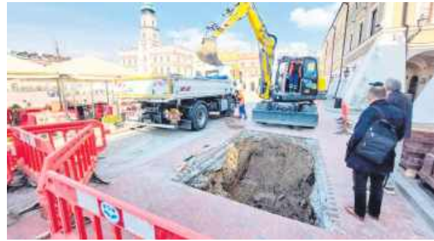
Prace poprzedziły działania przygotowawcze prowadzone przez Przedsiębiorstwo Gospodarki Komunalnej w Zamościu. Zdemontowano fragment nawierzchni, a następnie usunięto warstwy pod nią. Fot. Konrad Sinica
