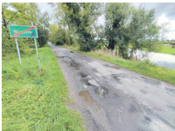
Już za kilka dni ma się rozpocząć remont drogi powiatowej z Wiązowa do Janowa
