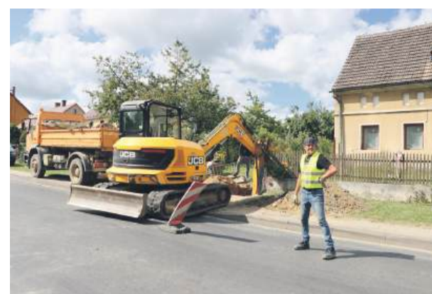
W Jegłowej prowadzone są równoległe dwie inwestycje – budowa sieci kanalizacji sanitarnej wraz z oczyszczalnią ścieków oraz przebudowa sieci wodociągowej
