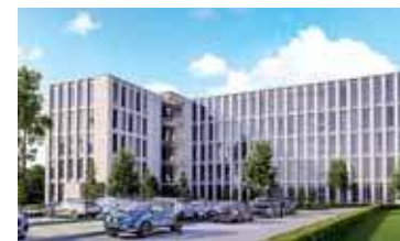
Realizacja Budowy Centrum Administracyjnego
