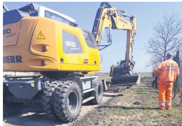
Prace drogowe w Krzewicy i Wasylowie już trwają. Fot. Wójt Gminy Ulhówek
