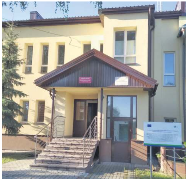
Budynek Samorządowego Centrum Kultury od lat jest siedzibą koła gospodyń.
