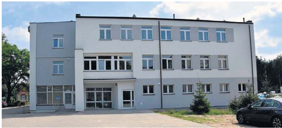
Korzystanie z dwóch źródeł finansowania tych samych prac budowlanych oraz zapłata 240 tys. złotych za niewykonane prace budowlane, bez zawarcia odpowiedniej umowy i zaewidencjonowania tych kosztów to tylko część nieprawidłowości w golubskim szpitalu
