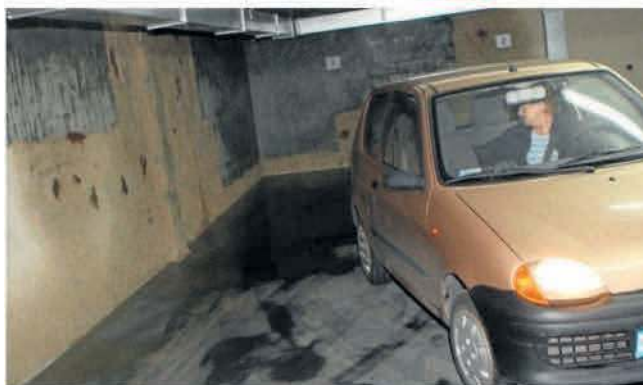
Pani Janina, mieszkanka bloku przy ul. Frąckowskiego 15, parkuje w zalanym podziemnym garażu. Fot. Karol Nagórski
