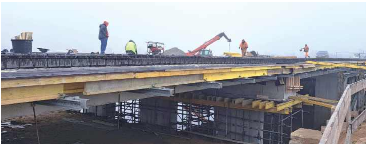
Jednym z elementów remontu na odcinku Wysokie-Rudniki jest budowa mostu
