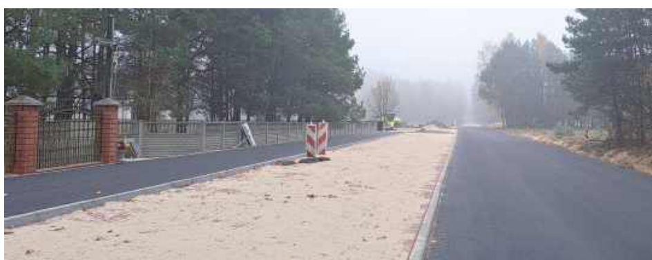
W ramach inwestycji, na drodze powiatowej powstaje m.in. ścieżka pieszo-rowerowa
