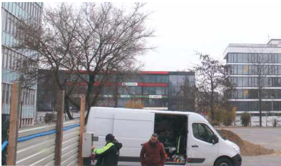
Na ogrodzonym placu budowy pojawiły się już oznaki pierwszych prac, m.in. doprowadzono energię. Po lewej stary budynek starostwa, tzw. Lipsk
