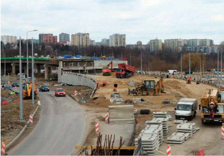
Przebudowa skrzyżowania ul. Krochmalnej z ul. Damentową
