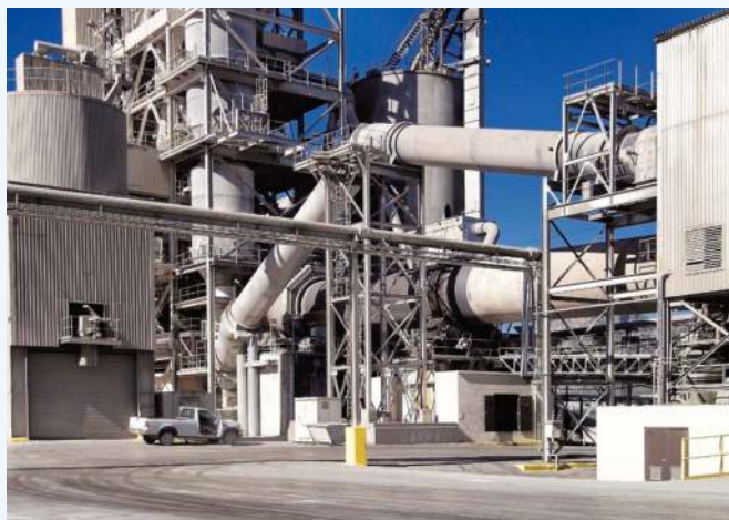
Fragment instalacji zwykłej cementowni
