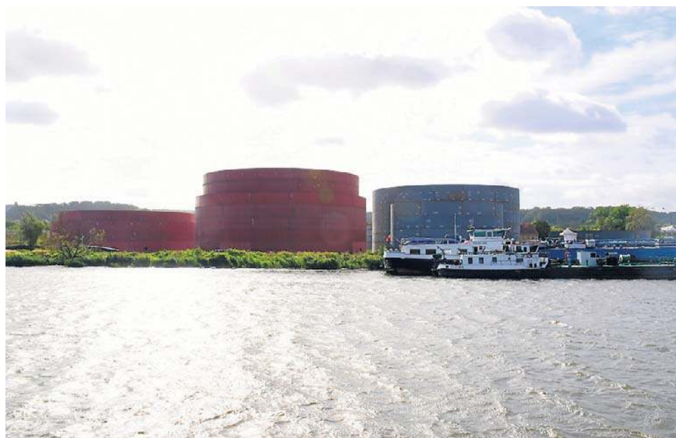
Wniosek inwestora obejmuje budowę bazy paliw. To właśnie ta inwestycja od miesięcy budzi sprzeciw mieszkańców Podjuch
