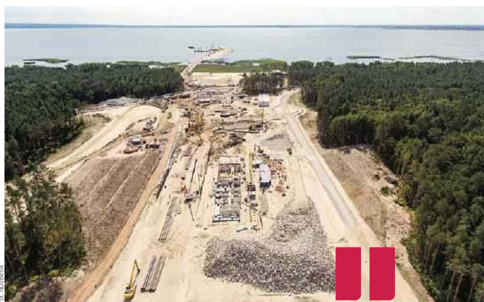
Za zajęcie kawatki terenu na potrzeby budowy przekopu gmina Sztutowo otrzymała ponad 200 tysięcy złotych odszkodowania
