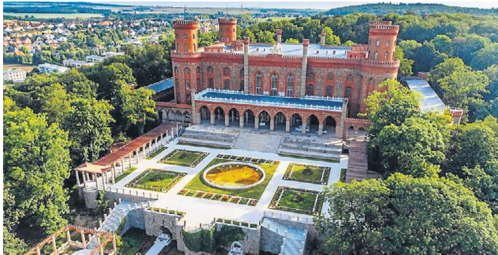
Pałac Marianny Orańskiej jest jednym z najpiękniejszych zabytków na Dolnym Śląsku. Od lat prowadzone są kosztowne remonty, które podniosły obiekt z ruin
