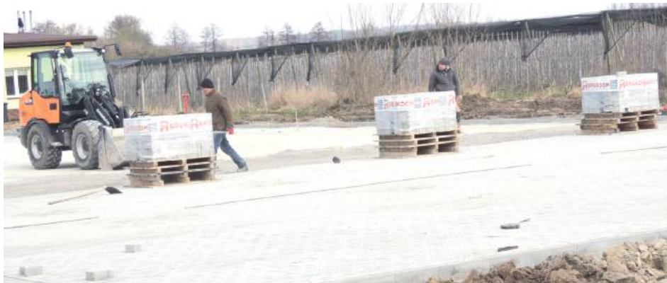
Aktualnie na placu, na którym w przyszłości będą mogły parkować samochody, układana jest kostka brukowa
