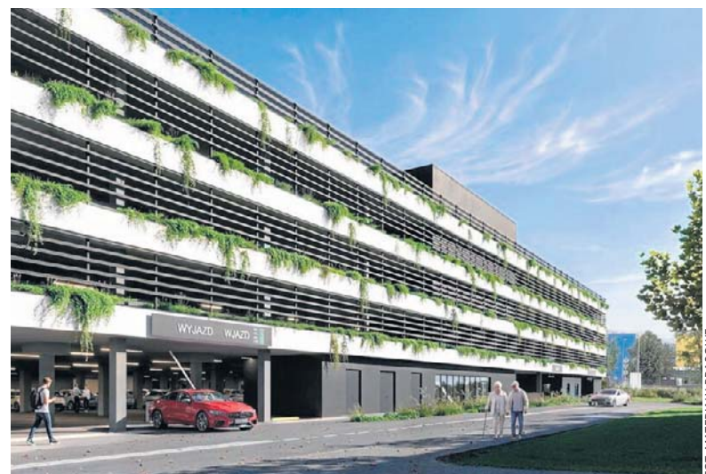
Nowy parking przy szpitalu będzie miał cztery kondygnacje
