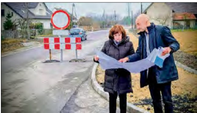
Wicestarosta powiatu opolskiego Leonarda Płoszaj dogląda postępów prac przy rozbudowie ul. Spórackiej w Krasiejowie.
