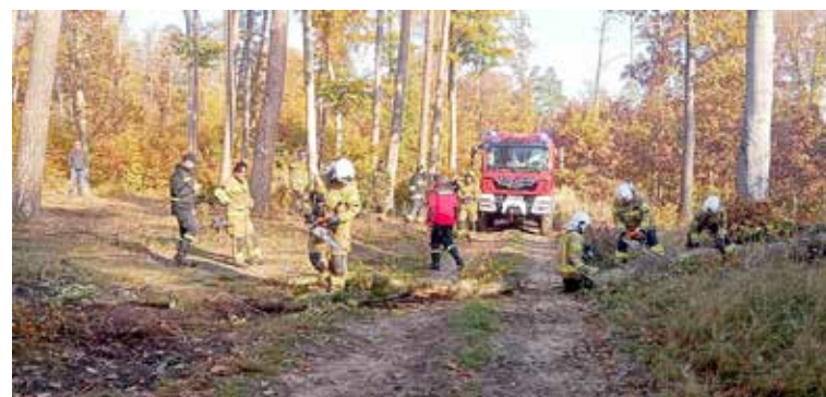
Usuwanie drzew z przebiegu drogi to jedno z zadań przygotowanych dla strażaków
