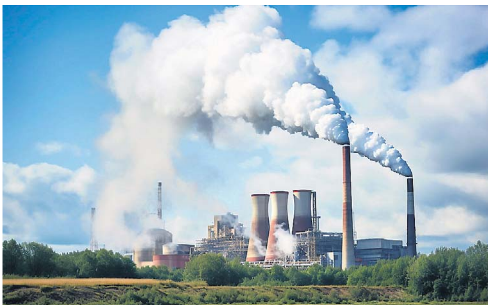
System ciepłowniczy w Polsce wymaga ogromnych nakładów inwestycyjnych
