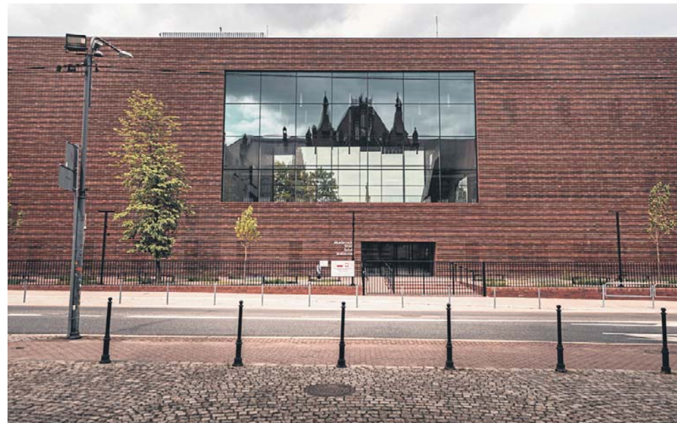
Nowy budynek Akademii Muzycznej w Katowicach. Nowoczesny gmach przy ul. Wojewódzkiej skrywa salę operową z unikalną akustyką i systemem izolacji
