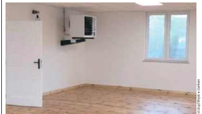
Prace modernizacyjne, sfinansowane przez gminę, objęły m.in. odświeżenie wnętrza oraz wymianę wyposażenia
