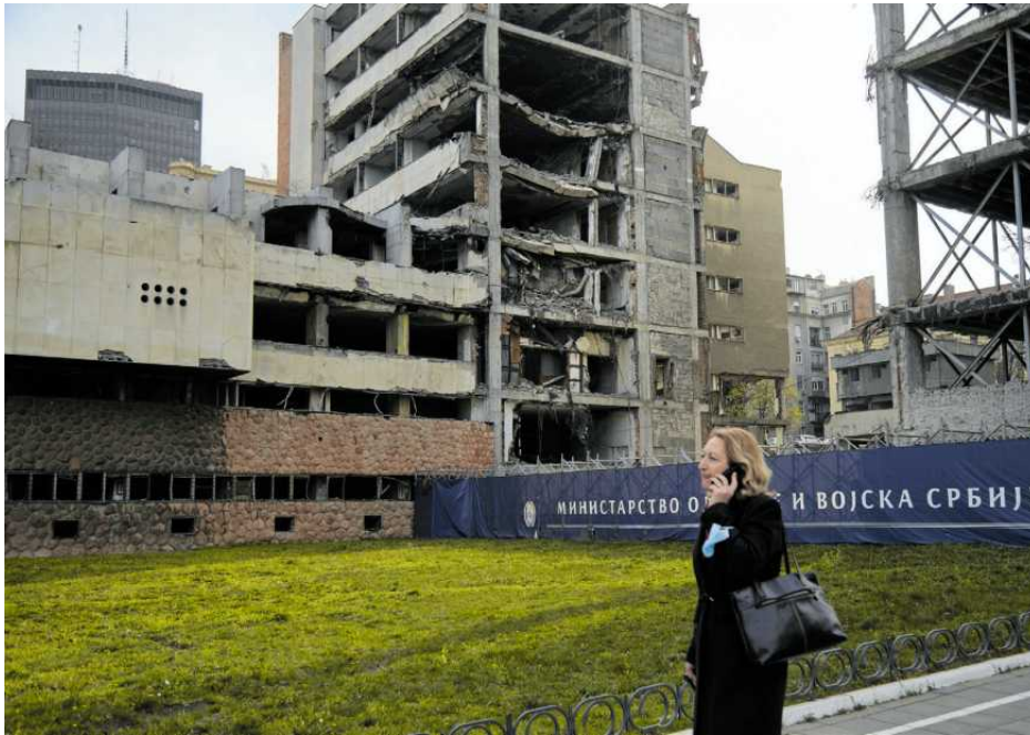
• Budynek zbombardowany podczas kampanii NATO w 1999 r. w Belgradzie
