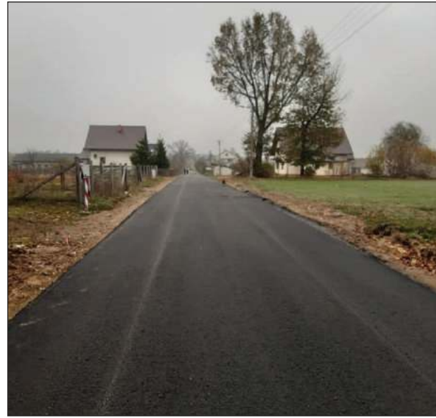
droga w Leonowie
